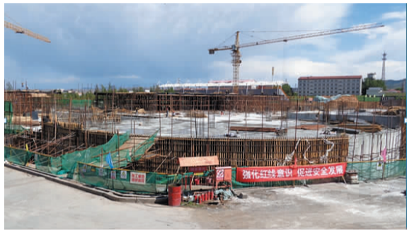
(地下室(1-16/A-K)轴已全部封顶)
