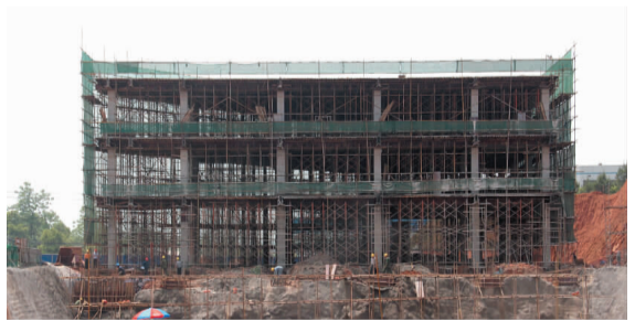
(信息大楼裙楼主体工程完工)
